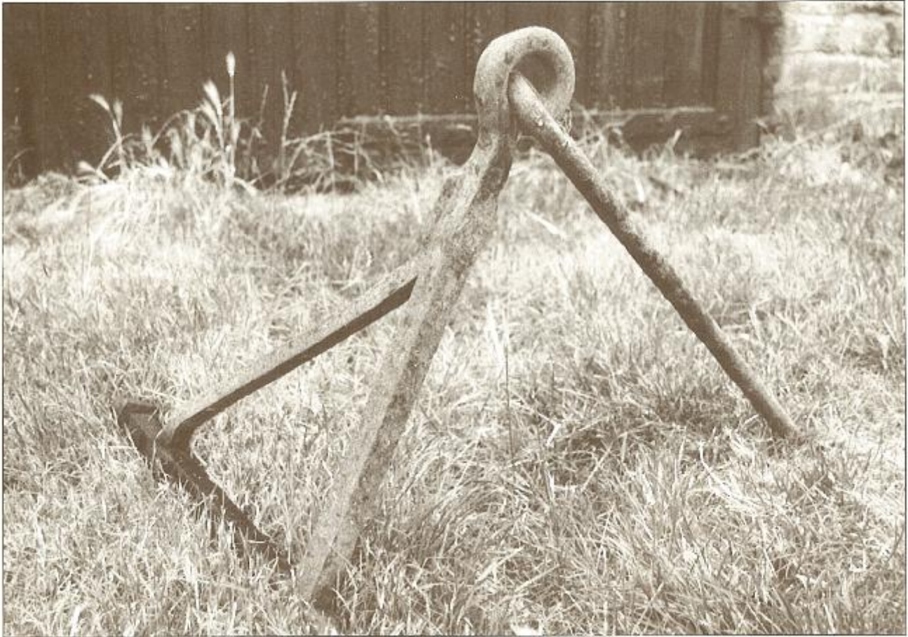
Een oude, handgesmede vloedwachter van de sluis van Prosperpolder (Prosper van Arenbergpolder). (privé-verzameling, C. Adriaenssens, Knokke).
