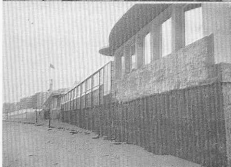
ONDER : de badinstelling van het Zoute waar voorheen het zand tot boven het onderste zwart gedeelte reikte.
