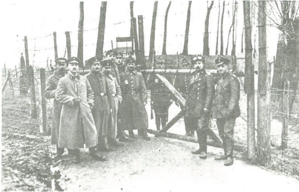
Hier een grenspost tussen Sluis (Heile) en Middelburg in België. Links een ijzeren grenspaal met daarvoor de draad met hoogspanning waarvan de witte isolatoren goed te zien zijn. Boven het hoofd van de Duitse schildwacht (met pinhelm) een bord, rood-wit-blauw geverfd. Achter de slagboom staan twee Nederlandse gemobiliseerden. Foto gemaakt in 1916. (Archief Emile Buysse - Sint-Andries).
