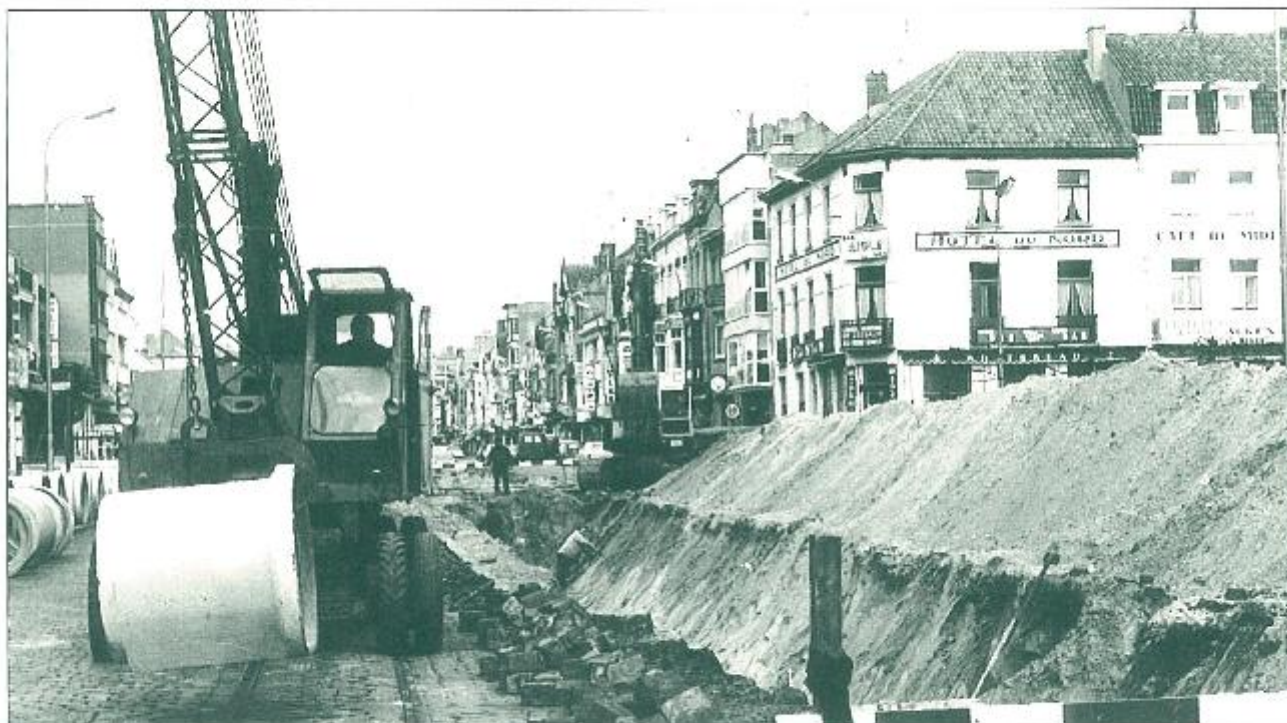
1969 - Er wordt een nieuwe regenwaterleiding voorzien in de middenberm van de Lippenslaan. De transporen werden uitgebroken en de «asfalt» deed zijn intrede. De haagjes en bomen verdwenen, in de plaats kwamen bloembakken en de nieuwe «autostradeverlichting».
