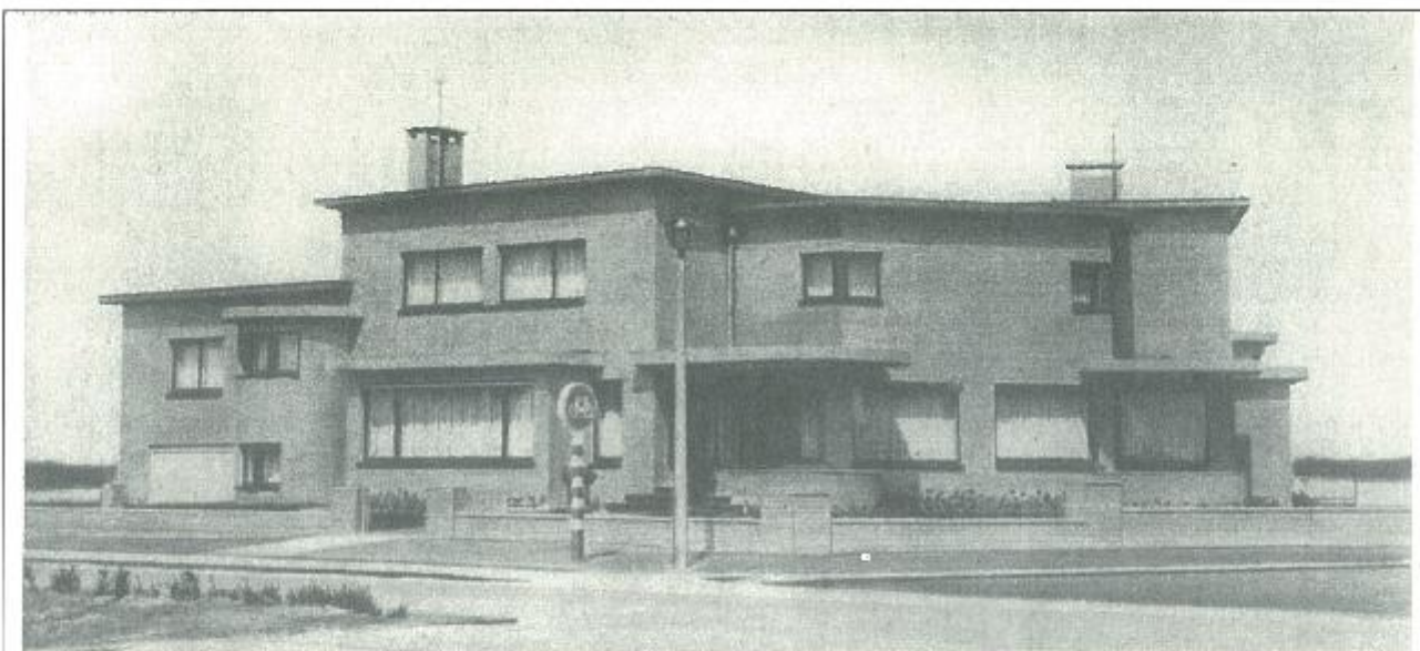
L'une des façades latérales des villas « Yvette » et « Jacqueline », l'arch. Vervaelcke, Le Zoute, exécutées extérieurement et intérieurement en matériaux céramiques de la S. A. « Cerabel ».
