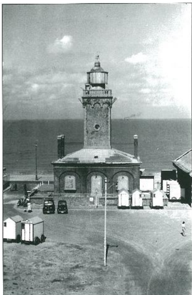
Het gebouw hart naar de sloping.
