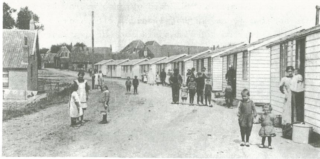
Woningen voor de Belgische vluchtelingen te Zierikzee, geplaatst op een terrein buiten de Zuidhavenpoort. Photogr. opname in 1916.
